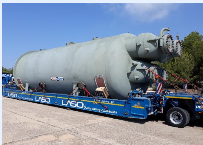
Trasllat i treballs de preparació dels SR per a la seva instal·lació a CN Vandellòs II.
