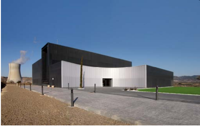
L'edifici del Centre d'Informació d'ANAV a CN Ascó
